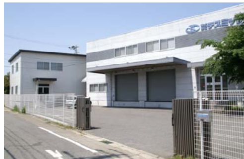
EMS事業本部 ディスクリート/はんだ槽 実装工場
