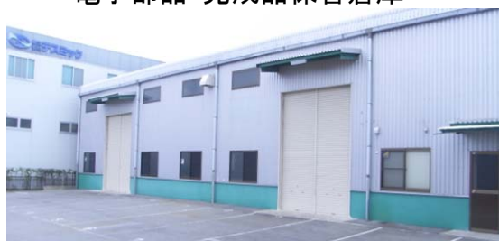
EMS事業本部 電子部品・完成品保管倉庫
